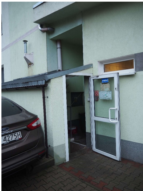
Zdjęcie 2. Zejście do kotłowni – wnęka – preferowana lokalizacja falowników
